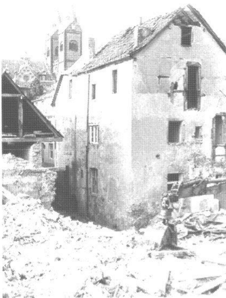
Abriss des Hauses Adolf Michel im Jahr 1975. An dieser Stelle wurde ein Wohnhaus und das Restaurant "Arenberger Stuben" errichtet.
