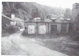
Zwischen dem Baubestand des 19. Jahrhunderts und der Aufbereitung als jüngstem Bauwerk am Heinrich-Schacht liegen die übrigen Tagesgebäude. Im Norden erhebt sich das noch bestehende *Transformatornhaus*, das als niedriges, eingeschossiges Gebäude mit Satteldach ausgebildet worden ist. Zahlreiche Belüfterkuppeln ragen aus dem Dach heraus, ein Umspannturm hebt sich am Westende des Hauses aus dem Dach heraus. An
