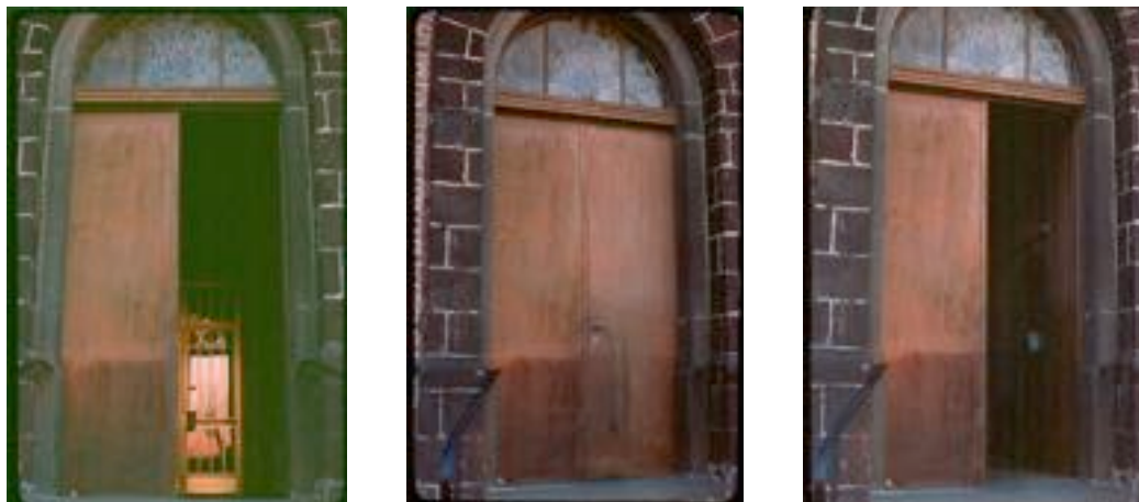
ehemalige Türen der Pfarrkirche
